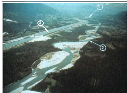
Aménagement hydroélectrique de Chautagne. 1/ Retenue ; 2/ Partie court-circuitée (débit réservé 10 m 3 /s) ; 3/ Canal de dérivation. Photo : PIREN Rhône.
